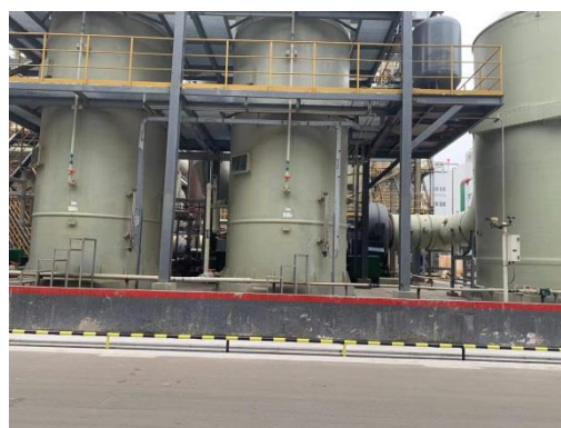
废气预处理罐区围堰
