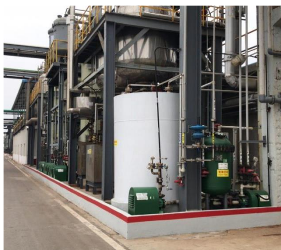
废气预处理罐区围堰
